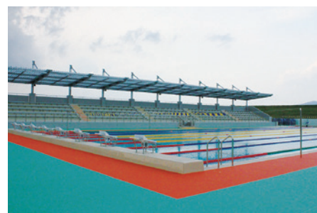
一関水泳プール/岩手県
