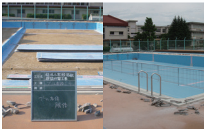
既存FRPプールは解体して新校舎で再組み立てしました。
