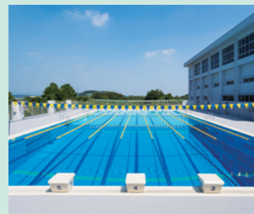
2016年 福岡県消防学校 水難救助訓練を行う大水深プール。 水深1.5m~5.0m
