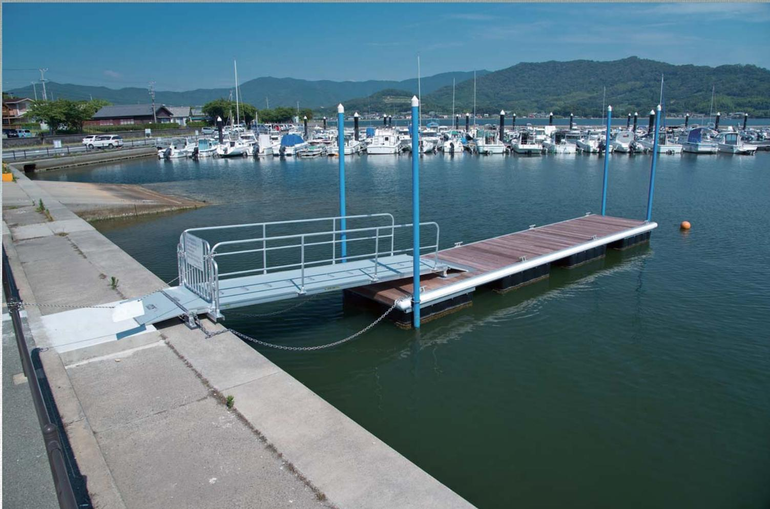
公共マリーナが、水難事故や災害時の救急・救命活動や資材運搬など水上と陸上とを結ぶ防災拠点として機能することを目的とした「防災栈橋」が浜名湖の公共マリーナ4施設に整備されました。防災栈橋は、水上デッキ面積を広くし、架橋スロープも拡幅と段差をなくした構造により、けが人等をストレッチャー（担架）に乗せたまま救急車まで移送することが可能になっています。
