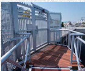
張り出しデッキ
