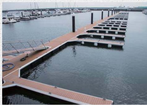
開業から19年経過した全隻海上係留保管の横浜ベイサイドマリーナでは、係留桟橋の老朽化が問題となり、特に木製浮桟橋の老朽化は利用者の安全性の確保と、景観、利便性の維持・向上のための対策が急がれていました。そこで木製浮桟橋リニューアル5年計画が策定がされ、平成22年から段階的に実施し平成27年に完了いたしました。当初計画では、既設杭を流用し既設レイアウトのままのリニューアル計画でしたが、リニューアルが進むにつれ、1シップ1バース(シングルバース)の要望と60フィート以上の大型艇やカタマラン艇の係留バースの要望が高くなり、最終年度で実施されたC5,C6,D2バースは、その要望に答えるため新規係留杭による新規レイアウトの係留桟橋が整備されました。5年間のリニューアル工事では、綿密な工事計画と利用者への丁寧な説明によりマリーナの営業および利用者の安全性と利便性に支障をきたすことなく、スムーズに実施されました。
