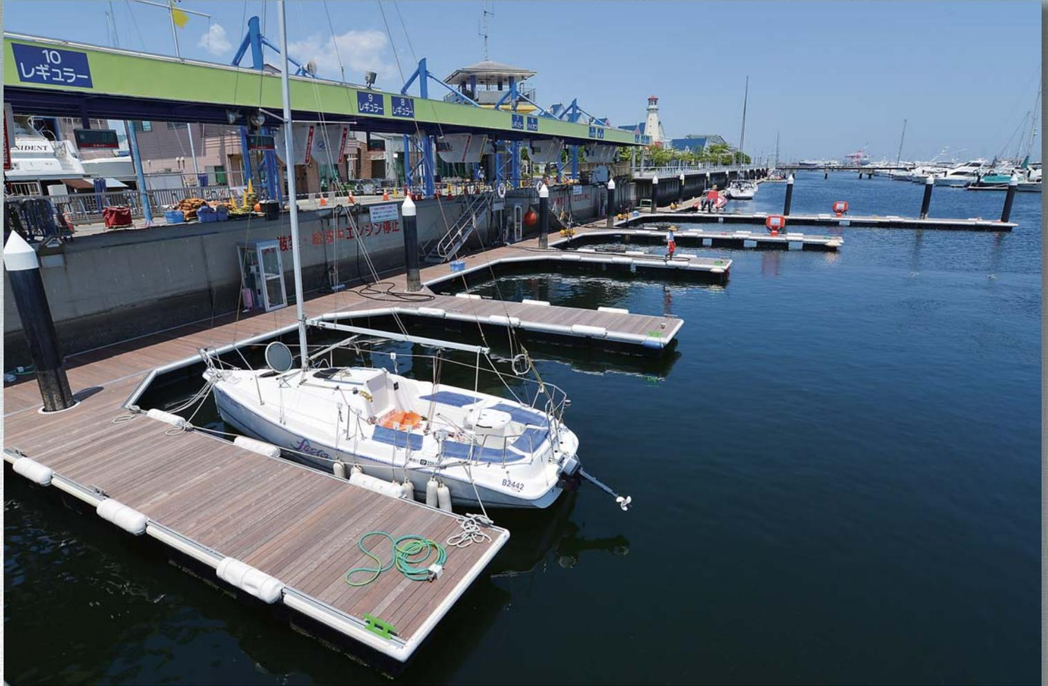
開業以来17年が経過し、浮栈橋の老朽化による腐食と乾舷低下が目立つようになり、また大型化するボートへの対応のために給油設備と共にリニューアルされました。栈橋計画は既設杭を活用したのですが、バースの拡幅による変則的な杭配置にも栈橋の性能・機能を損ねることなく効率的に設置されています。
