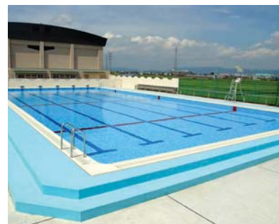
写真上: ヤマハFRPリニューアルプール 茨城県神栖町立息栖小学校(1994年) 写真下: ヤマハFRPリニューアルプール 京都府八幡市立八幡中央小学校(2003年)
