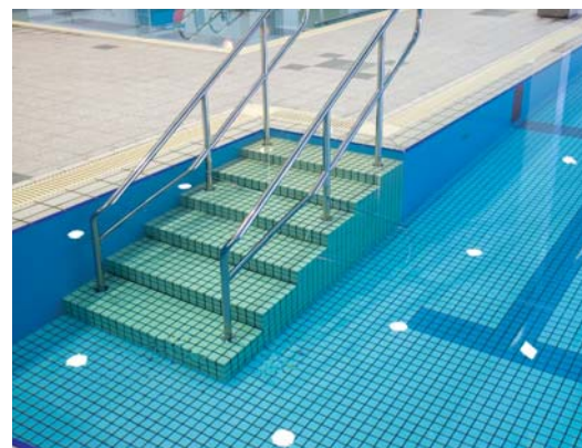
HAKUWAの25mプールに採用された新型のプラスセラミック
