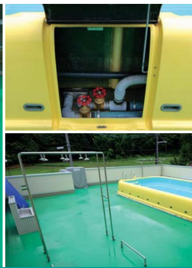
※テラスの勾配に合わせたコンクリート基礎をプールの下に設置
