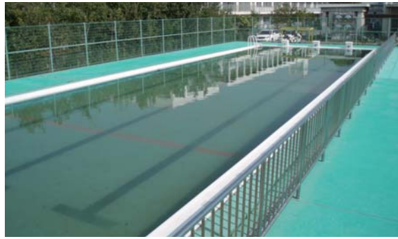
既存プール サイズ:25m×7m 材質:RC+アルミパネルカバー工法
