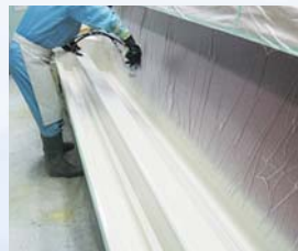
プールユニットの型となる「メ型」に表面塗装材となるゲルコートを塗布。
