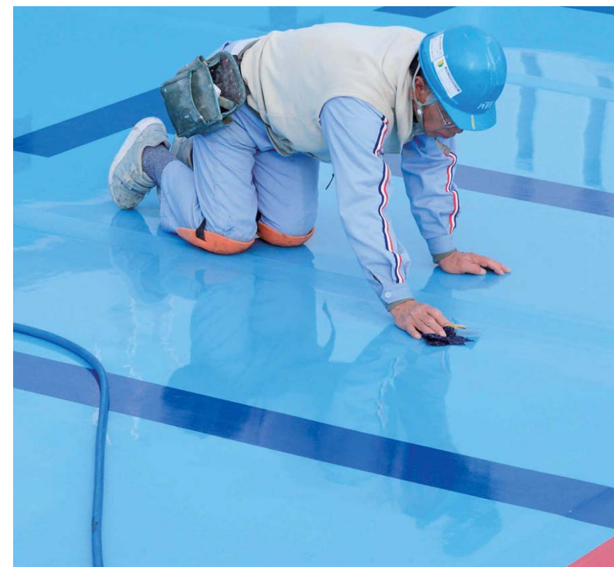
プール底版の仕上げ作業
