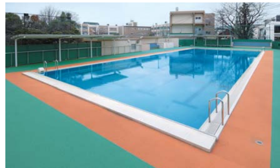
2008年改修プール サイズ:24.95m×9.95m 水深:0.9-1.1-0.9m 材質:FRP FR工法
