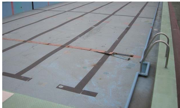
既存プール サイズ:25m×10m 材質:ST(鋼板)
