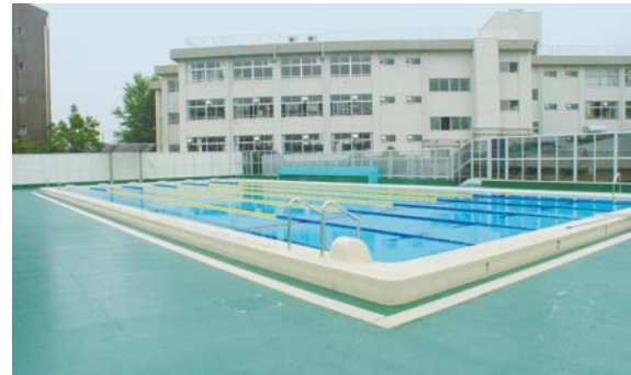
2010年改修プール サイズ:25m×9.95m 水深:1.0-1.1-0.9m 材質:FRP FR工法
