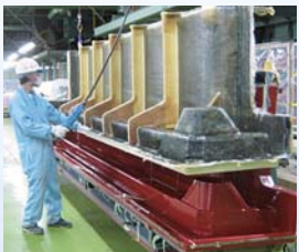
ポリエステル樹脂が規定上硬化したら「FRPメ型」からプールを離型。
