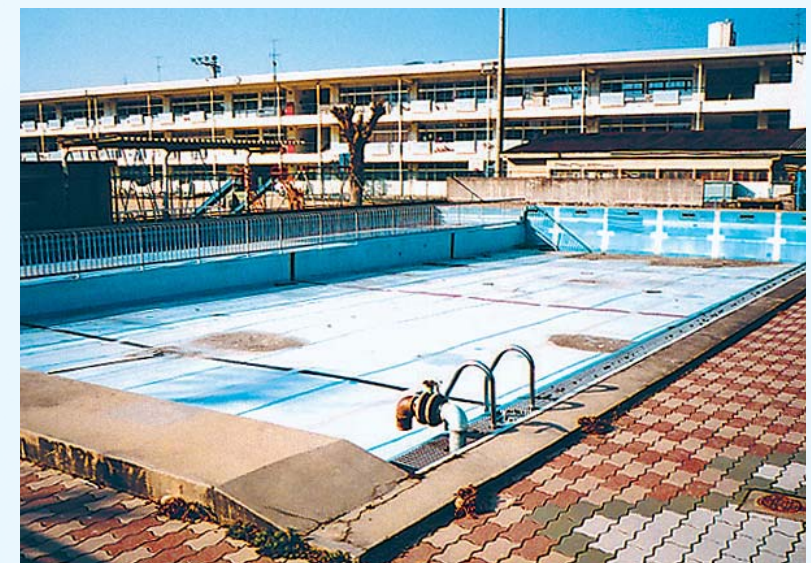
寒暖の差が激しい屋外プールは本体だけでなくプールまわりの老朽化が早い。
