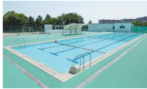
2010年改修プール サイズ:24.95m×6.96m 水深:0.9-1.1-0.9m 材質:FRP FR工法
