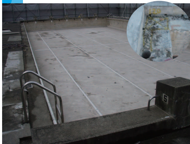
改修前コンクリートプール(全体的に汚れが目立つ。コーナー部は角が多く危険)
