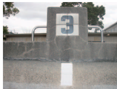
スタート台(高いスタート台は飛び込み事故が発生しやすい)
