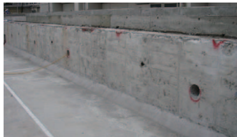
既存の配管を利用するため、金具取り付け位置のコア抜きを行なう
