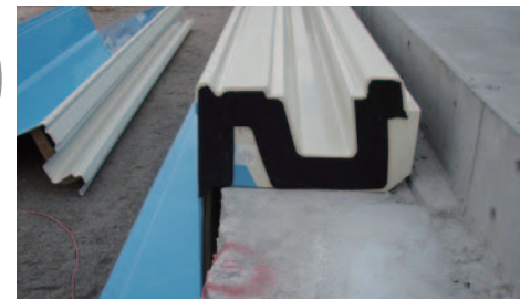
元のコンクリート躯体を利用して、FRPユニットを組み立てる
