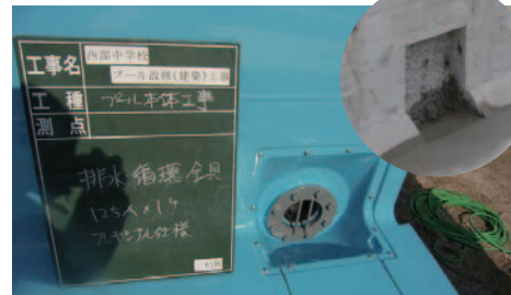
新設排水口部分はFRPボックスに合わせて最小限のカットを行なう
