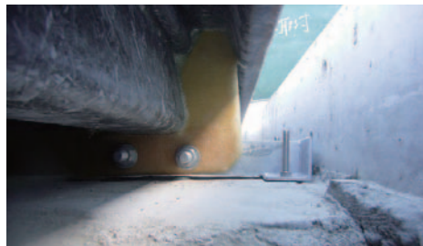
FRPユニットは、位置と高さを調整し専用の金物で元のプールに固定される
