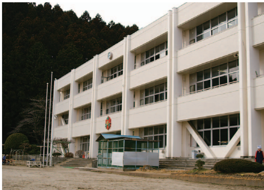
校舎は耐震補強が行なわれていたため大きな損傷はなかった
