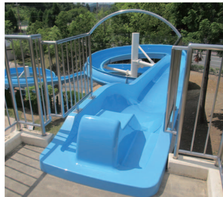
新設スライダーエントリーユニット部
