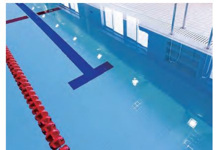
床面に施されたノンスリップパターン
