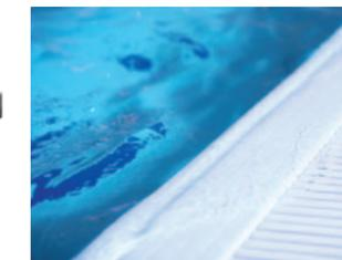
アクアピクスの反射波を小さくする大型のプールデッキとオーバーフロー溝
