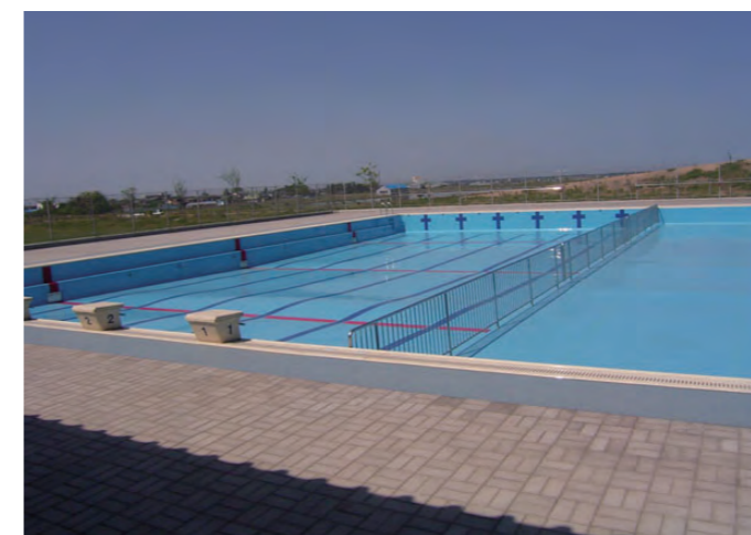
胎内小学校(新潟県胎内市)
