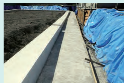
FRPプール布基礎とアクアエル設置床
