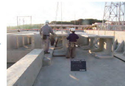
割り付け位置へ設置
