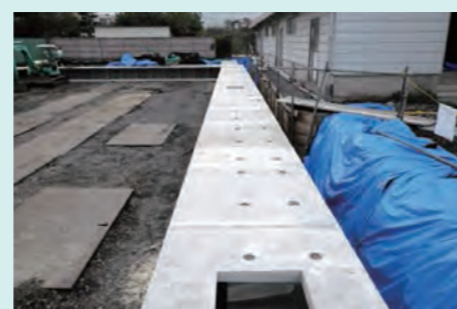
設置完了(点検口部分)
