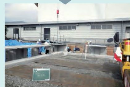
クレーン車で配置
