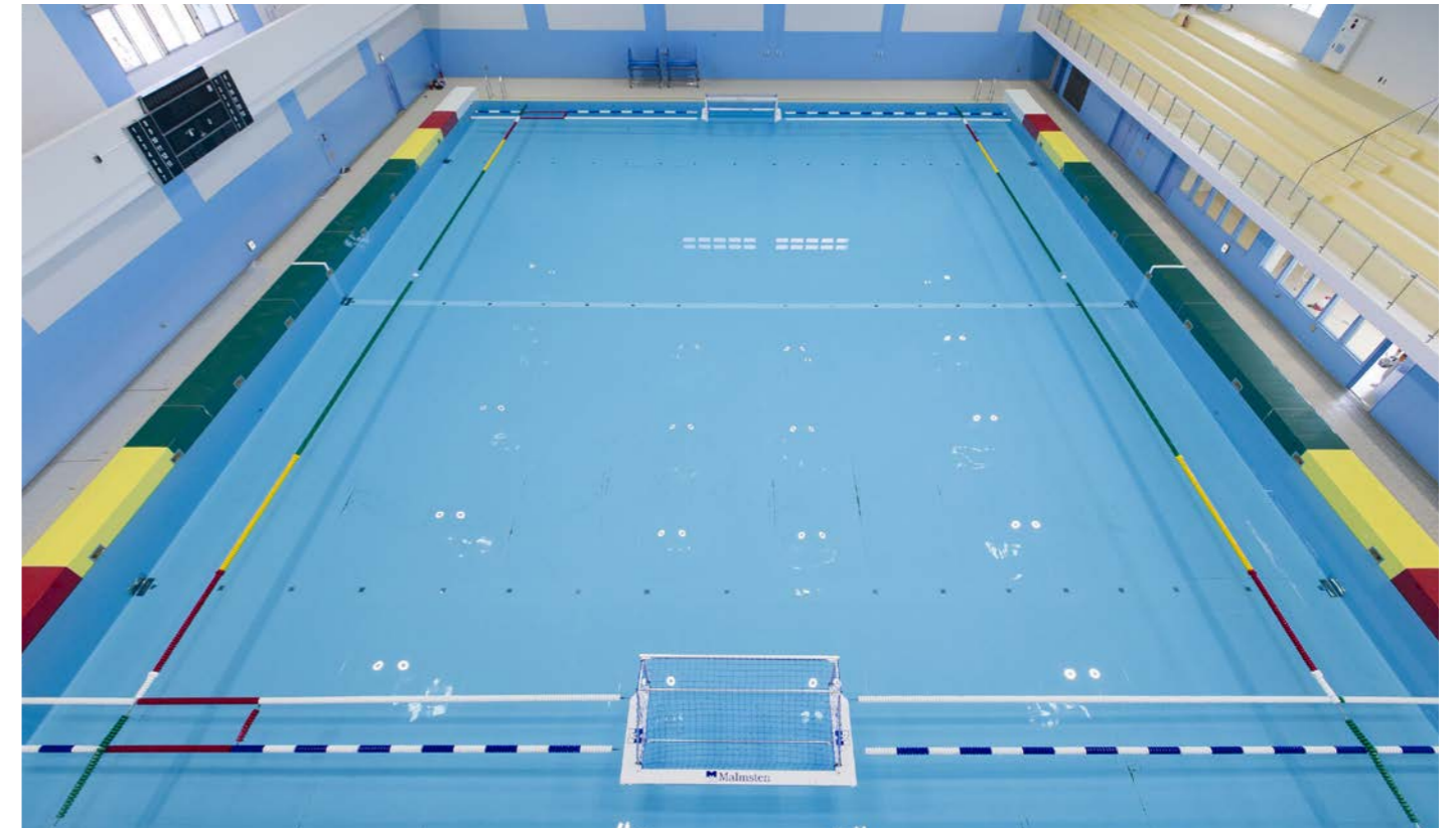
キャットウォークからの全景。公認水球プール(FRP製) プールサイズ 30m×25m 水深2m(女子水球フィールド 25m×20m)
