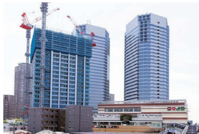
建設中のタワーマンションとジェクサーのある新川崎スクエア(手前)
