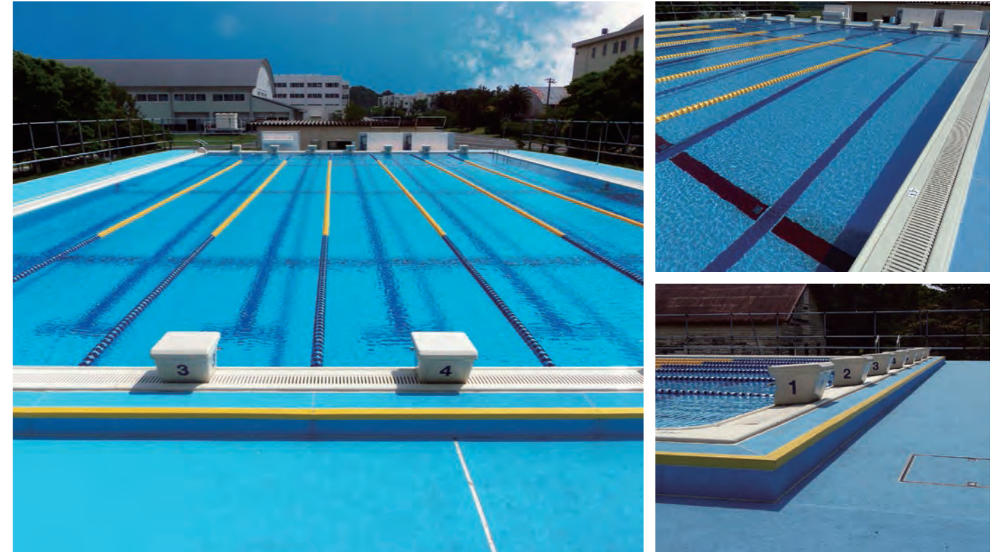
ヤマハFRPリニューアル工法で改修が行なわれた。
