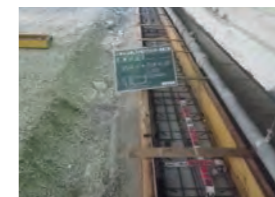
新設プール基礎工事
