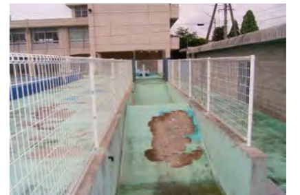
(改修前)シャワー
