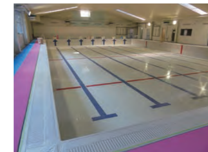
新設プール組立完了
