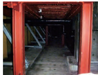
⑤新設プールピット
