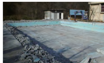
③コンクリートプールの上部撤去
