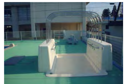
(改修後)シャワー ヤマハシャワーユニットを設置
