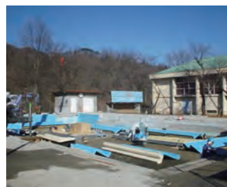
④FRPユニット搬入
