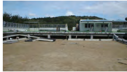
①床板撤去
