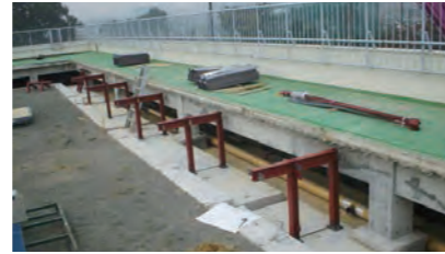
③新設プールサイド下地
