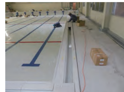
新設プール組立工事
