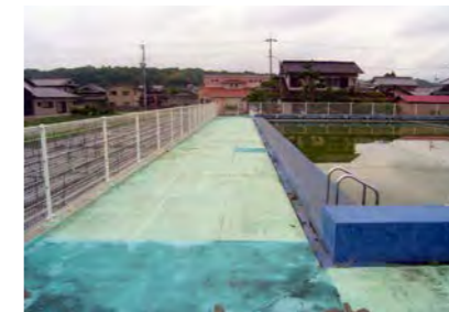
(改修前)プールサイド
