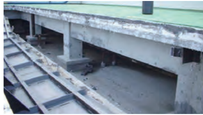
②側壁撤去
